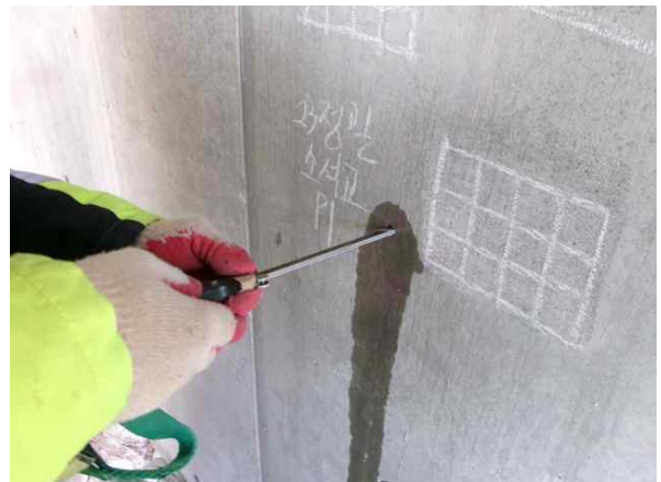
탄산화깊이 측정 현황
